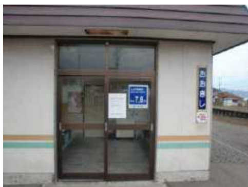
海拔表示板設置状況
