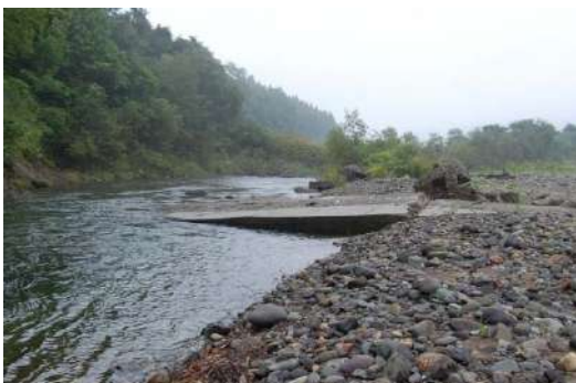
野田追川上流の流出した横断工作物
