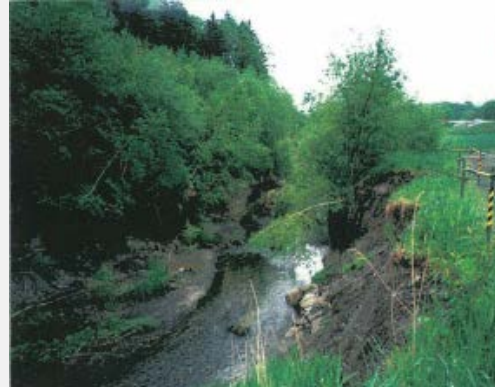
鎮錬川の河床洗掘
